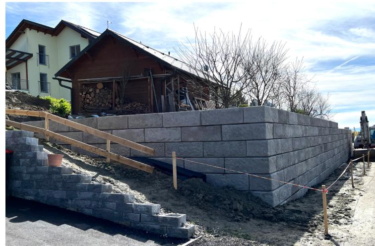
Errichtung einer 2,8 m hohen Stützwand als Abstützung des Gartens eines Familienhauses in Walding, mit einer Außenecke und einer Rundung am Mauerende. Zusätzlich wird für die Gartenbewässerung eine 2-Becken Betonzisterne mit je 15m<sup>3</sup> Inhalt eingebaut.
