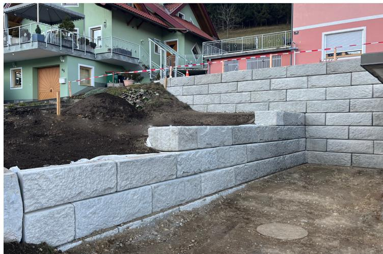
Dank der modularen Bauweise konnte eine Stützmauer errichtet werden, die die bestehende Garagensituation berücksichtigt. Dabei wurden verschiedene statische Anforderungen in der Mauer integriert, um sowohl den Parkplatz oberhalb als auch die Gartenfläche zu unterstützen.
