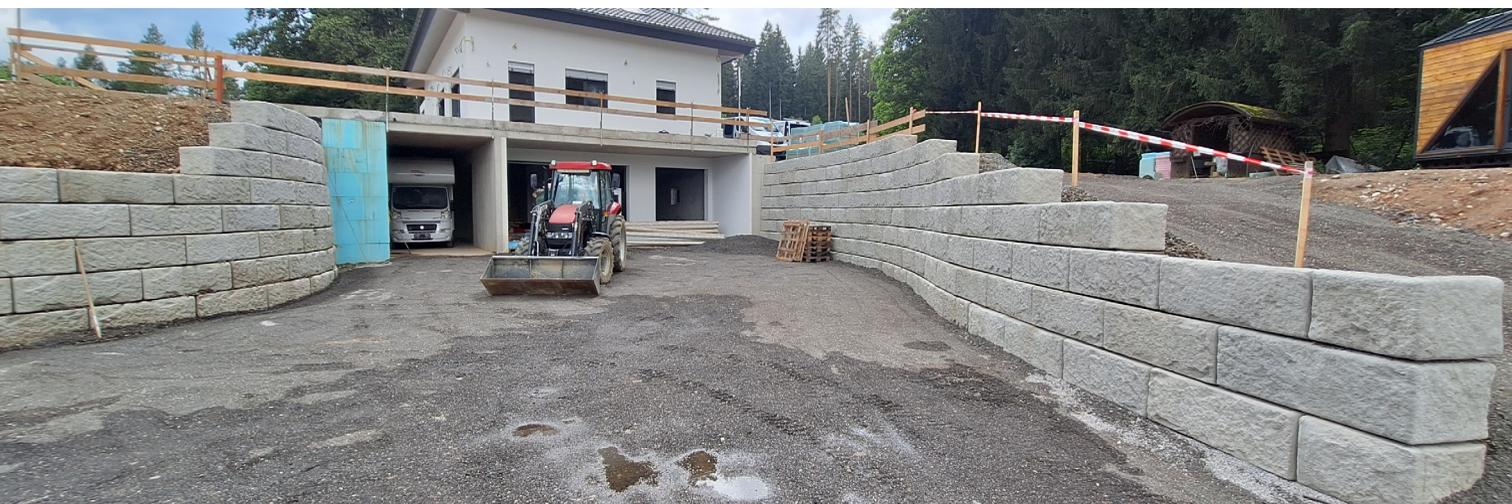
Mit dem SW-Stützwallsystem konnte einerseits die Zufahrt zum Haus gesichert und andererseits die Gartenfläche stabilisiert werden. Durch die Granitoberfläche der Steine fügt sich das Mauerwerk harmonisch in die Umgebung ein.
