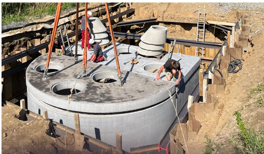
Errichtung einer Kläranlage für 2500 Einwohner mit den SW-Großbehälter Elementen AQUAstore, die mit geringen Einbaukosten und kurzen Montagezeiten punkten. Die Montage erfolgte durch unser Montageteam und die Verkehrsbeeinträchtigung durch Strassensperren konnte minimiert werden.
