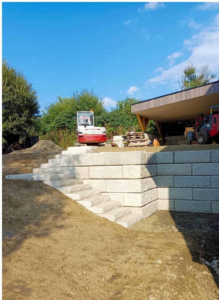
Dank des SW-Stützwandsystems konnte hier ein platzsparender Ab- bzw. Aufgang von der Einfahrt zum Kellerzugang geschaffen werden. Durch die SW-Stufenplatten wurde der vorhandene Platz optimal ausgenutzt.
